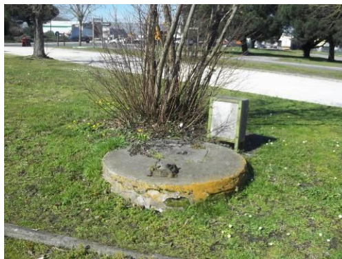
Figure n°10 : Puits communal 08035X0145.
